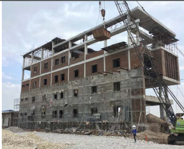
Nhà điều hành trung tâm – Center control building
