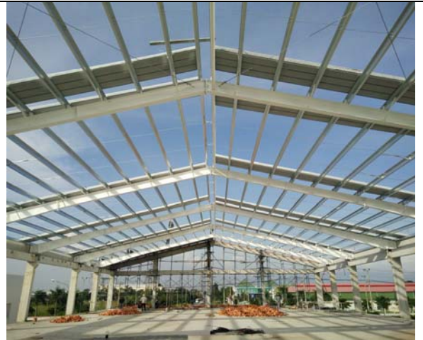
Lắp dựng kèo thép – erection of steel frame
