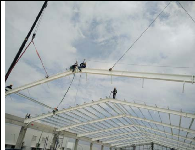
Lắp dựng kèo thép – erection of steel frame
