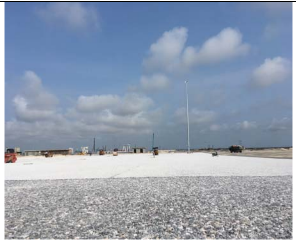
Lu lèn nề đường – Compacting base road
