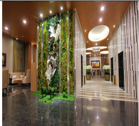
Hoàn thiện hệ thống MEP sảnh đón tiếp – Finishing MEP system at Lobby
