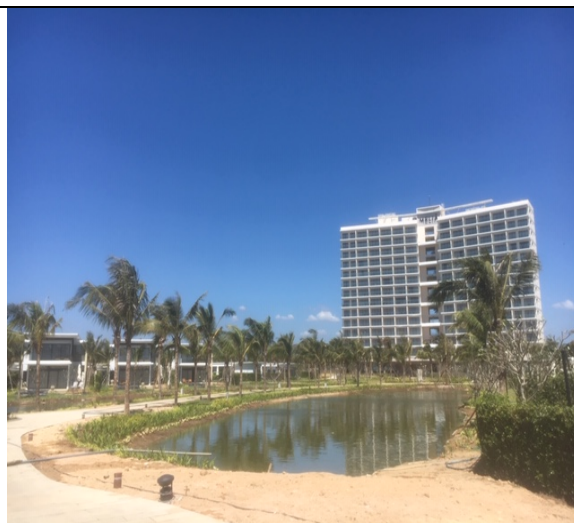
Hoàn thiện hệ thống đường – Finishing for road works
