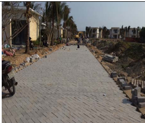
Công tác đường – Road works
