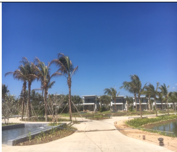
Hoàn thiện hệ thống đường – Finishing for road works
